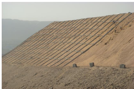
外排土场拱型骨架护坡
