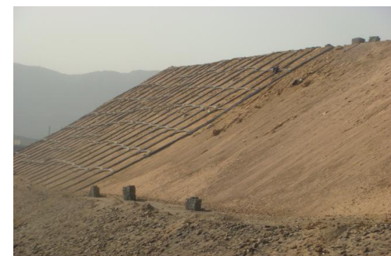
外排土场拱型骨架护坡
